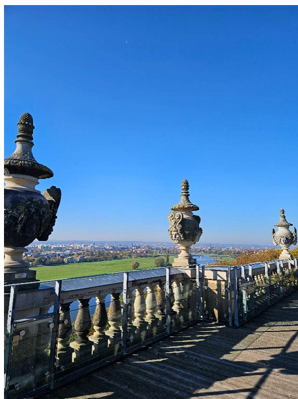
Dachplattform, © STESAD GmbH
