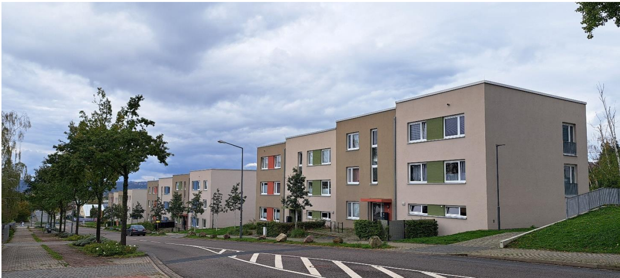
Abb. 2 vorhandene Bebauung entlang des Nickerner Weges
